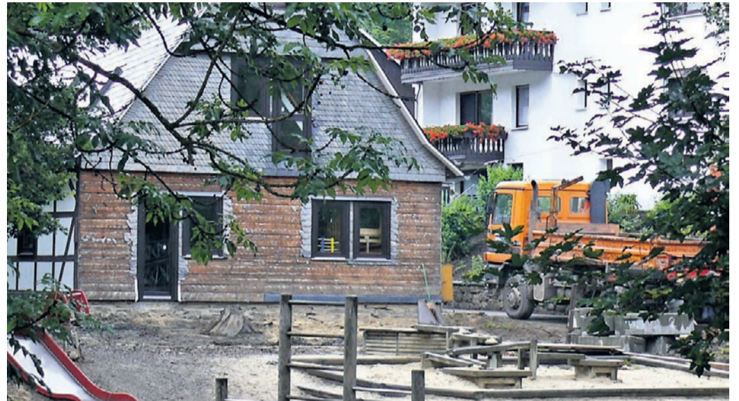
An den Schwalefelder Kindergarten wird ein Gruppenraum angebaut.
